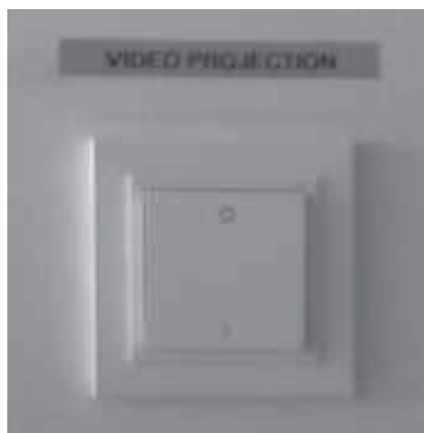
Interrupteur sans fil et sans pile pour les scénarios dans une salle de TP
