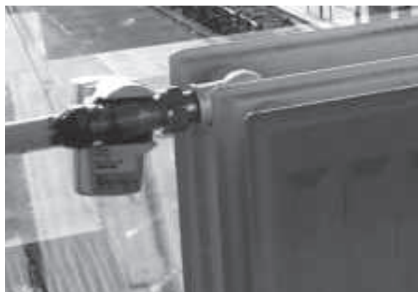
Vanne radio commandée située sur un radiateur
