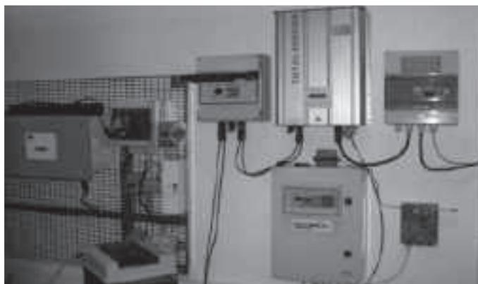
Différents onduleurs PV avec systèmes de mesure des puissances
