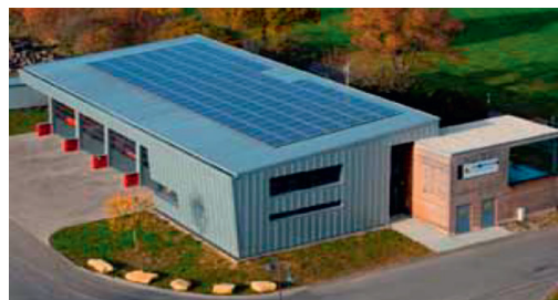
Figure 8 : Caserne de Pompier de BECKERICH Puissance de 29,52 KW, 164 Panneaux photovoltaïques Polycristallin, 5 Onduleurs. Source : Auteurs
