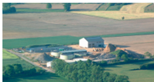
Figure 9 : Centrale bio gaz de BECKERICH Puissance de 850 KW électrique et 850 kW thermique Source : Auteurs
